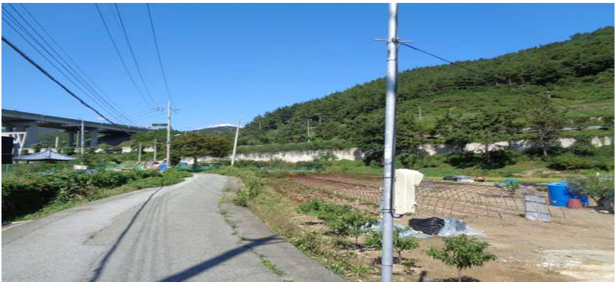
대상 옹벽 전경
